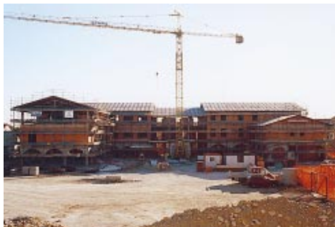
La "Casa del giovane" in costruzione presso il Centro Giovanile 2000, vista dal lato del cortile di accesso ai vari ambienti.
